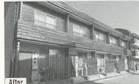
兵庫県宝塚市で、1階が商店、2階が住居のアパートをリノベーションした「INNO HOUSE」。内装にこだわった、周辺にない物件にするというオーナーの戦略が当たり満室に
